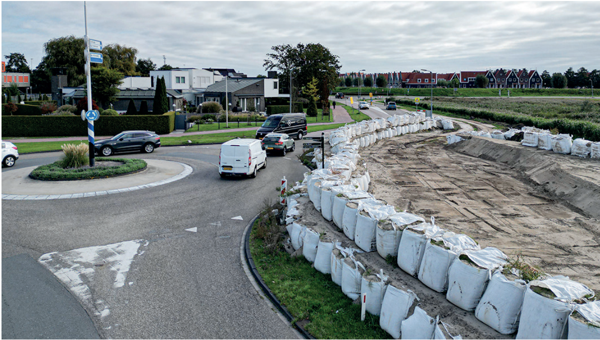
De rotonde Zeddeweg-Heideweg, waar straks het fietspad wordt verlegd en de weg opnieuw wordt ingericht.
